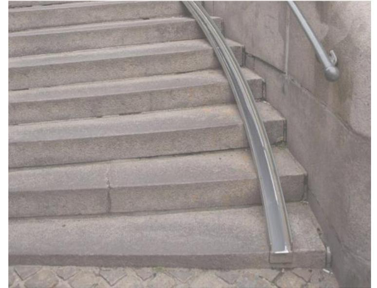
Perfil metálico para transporte de la bici
