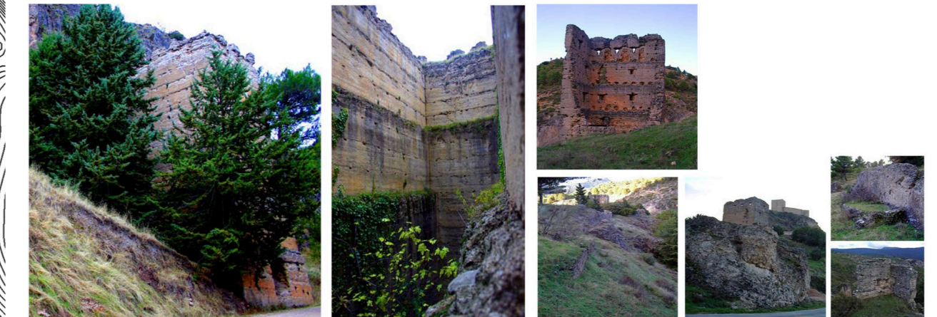
Torre del Agua. Vista exterior y del interior.
