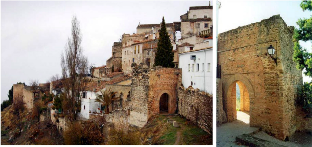
Puerta de Catena. Vista combinada de murallas almohades y cristianas y detalle de la puerta.
