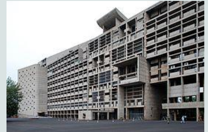
EDIFICIO DEL SECRETARIO
