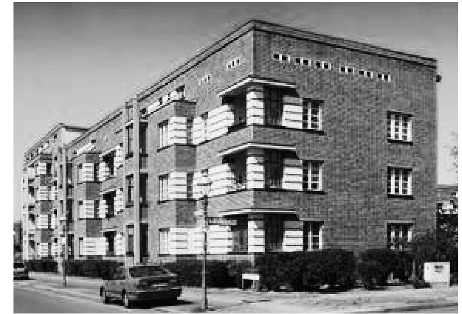
Viviendas en Schillerpark, Berlín (1924-1928)
