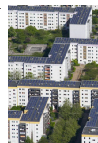
Ejemplo: Urbanización en Berlin con energía solar
