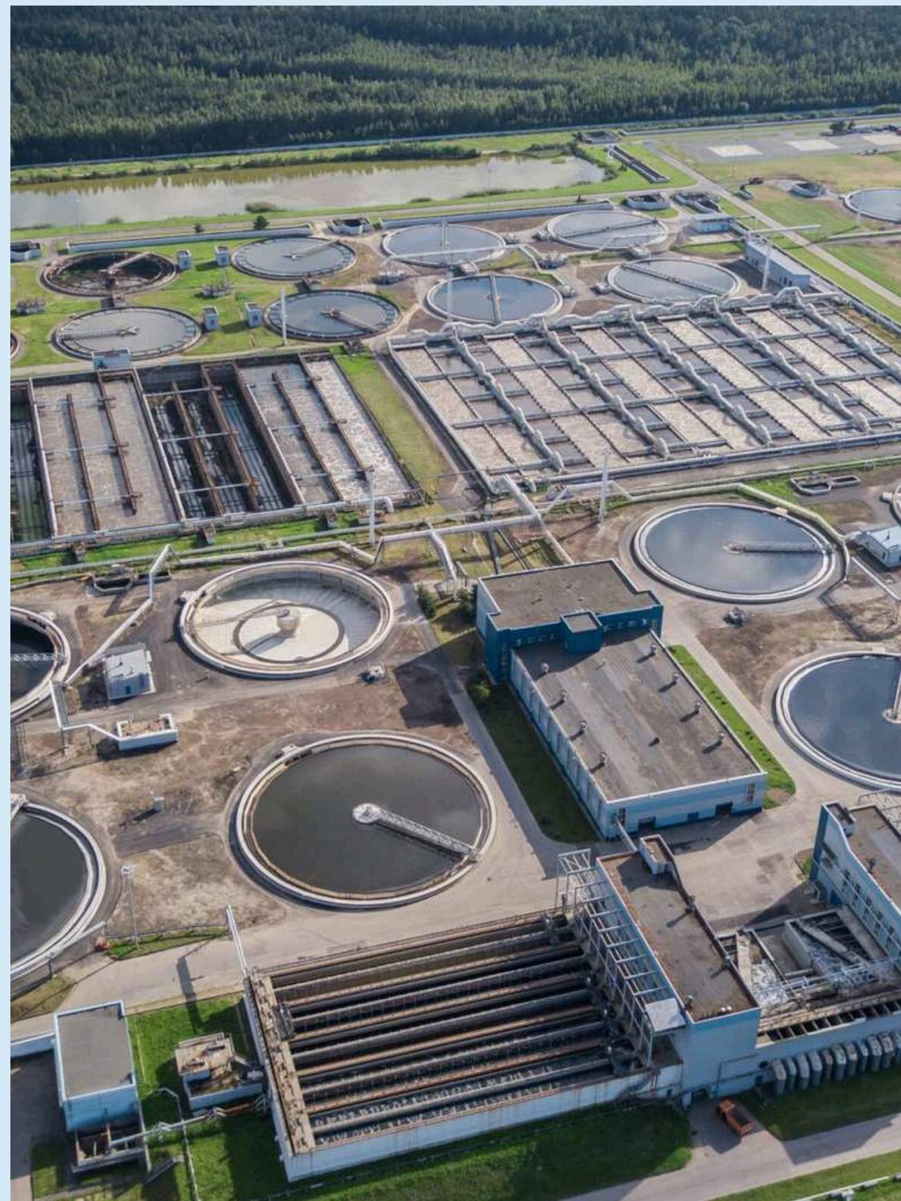
Tratamiento de las aguas residuales
